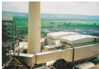
PPL - PA, USA (2 x 750 MWe)
